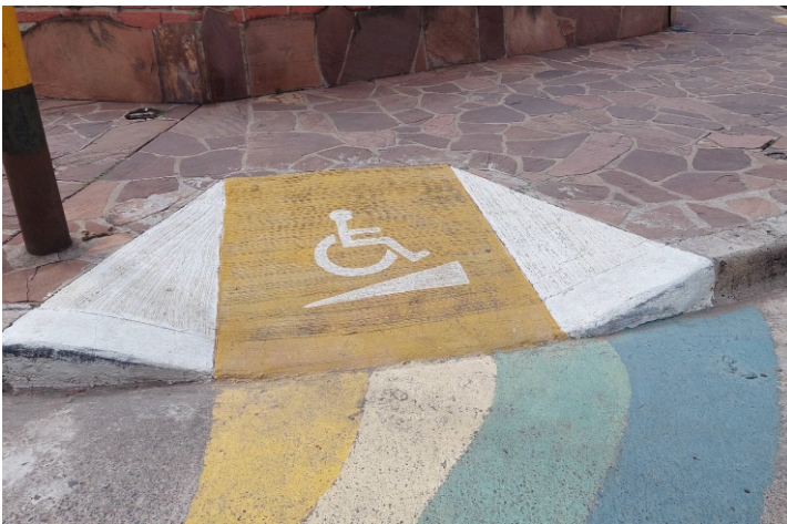
Figura 4. Vado en la intersección de la calle Coronel Dávila y Avenida Carrillo. B° C. de Nieva. Fotografía de las autoras
