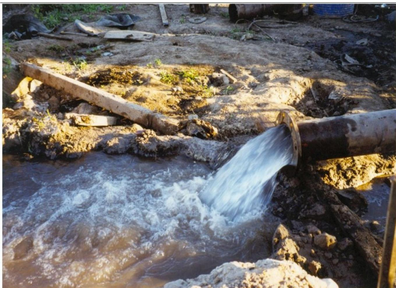
Fotografía 1. Vista de un pozo surgente que tiene un caño de descarga de 10 pulgadas de diámetro y está insertado en una zona cercana a Termas de Río Hondo, el cual arroja un caudal de 200 m<sup>3</sup>/hora.
