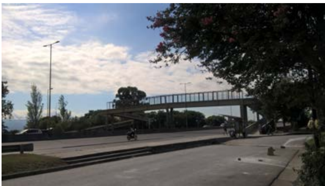
Figura N°10. Vista pasarela sobre Avenida General Savio. Fotografía: Julio Linares.
