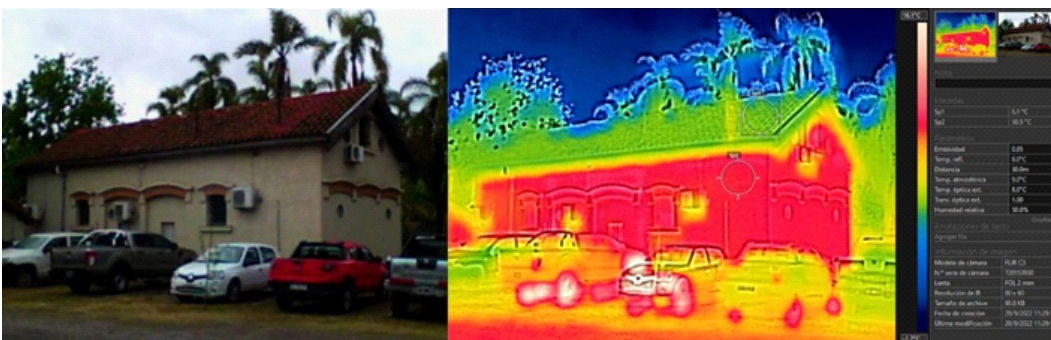
Figuras N°16. Vista exterior simultánea y termografía del frente norte. Fuente: elaboración propia.
