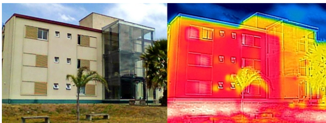
Figura N°2. Fotografía y termografía mediante cámara Flir C3. Fuente: elaboración propia.
